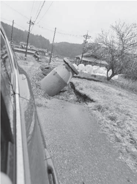
写真1 液状化により浮き上がったマンホールは通行の妨げとなった
