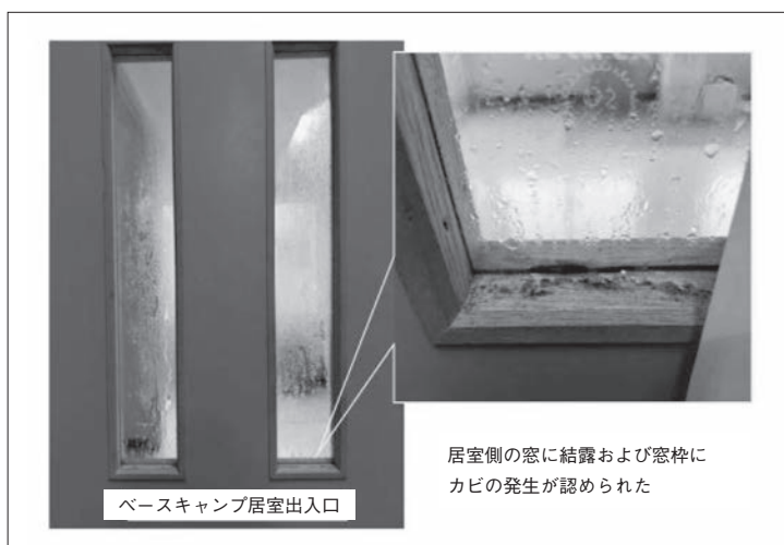
写真7 ドアガラスに発生した結露とカビ
