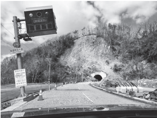
写真2 多くのトンネルで上部の土砂が崩れ落ちていた
